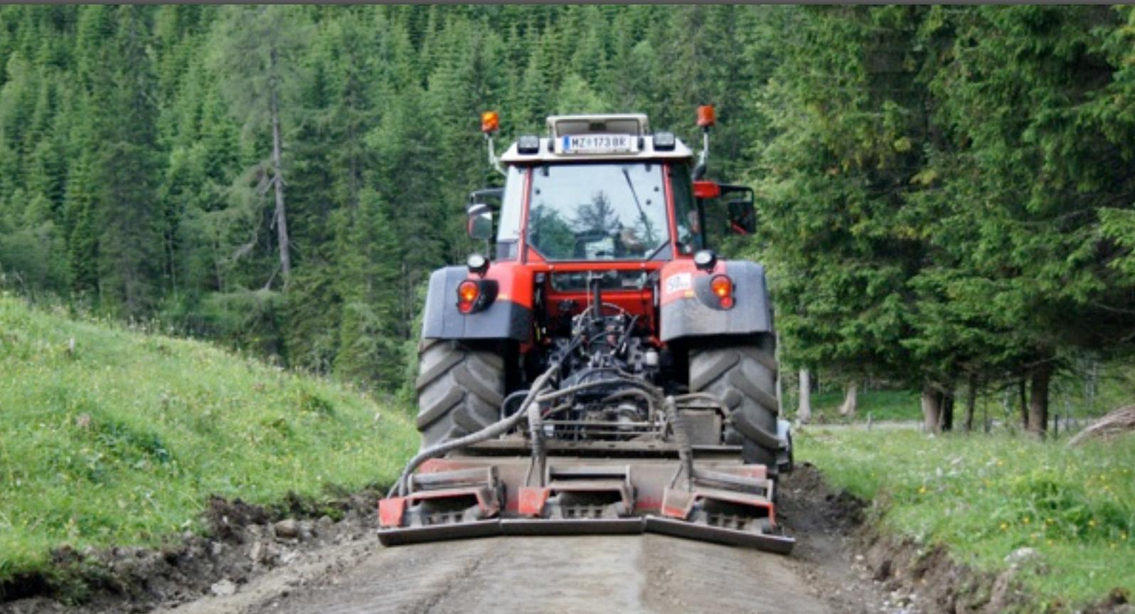
**Optimale Verdichtung bombierter Untergründe durch die 3-Teilung**
